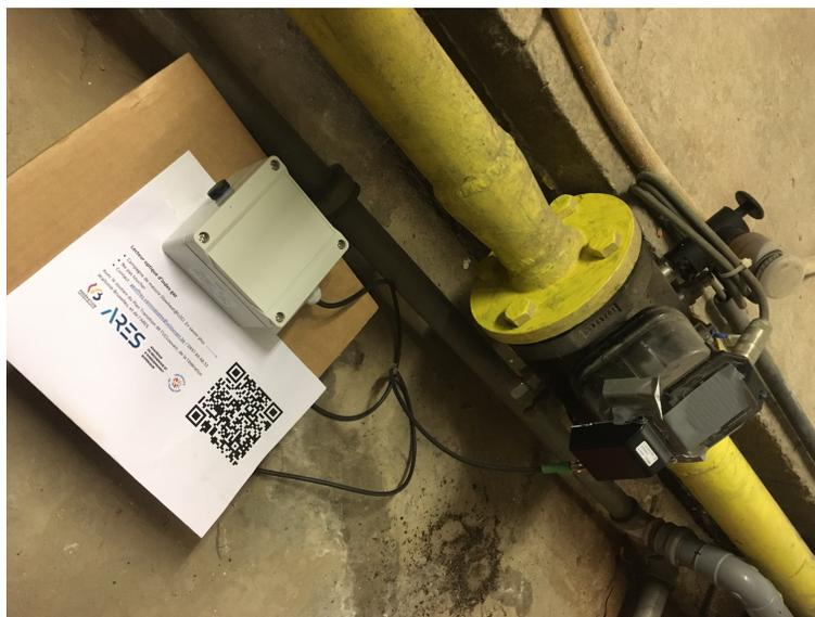
Figure 5 Photo du lecteur optique sur le compteur gaz
