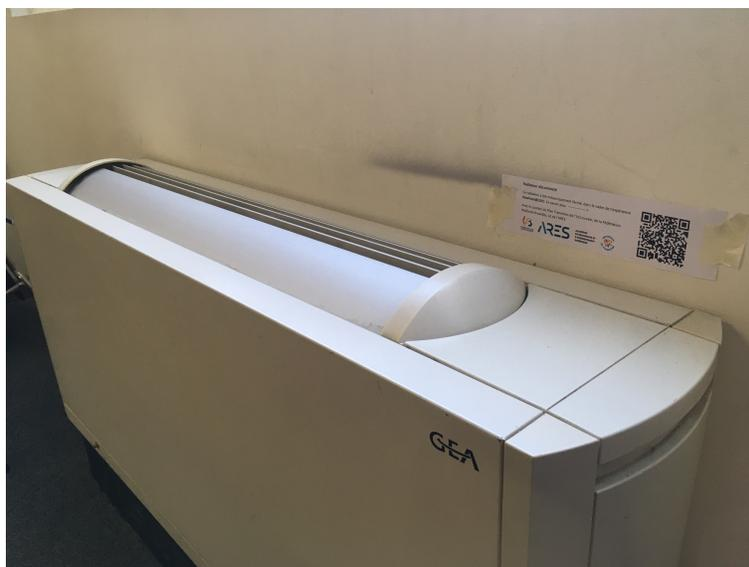
Figure 2 Exemple de ventilo-convecteur isolé en phase ZONAGE (ici dans le couloir du 4e étage)
